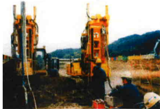
左:ポイント設置状況 右:削孔完了状況
